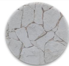
PIEDRA BLANCA NATURAL (ELEMENTO ESTRUCTURAL EN MURO)
